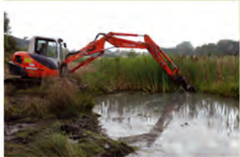
Baggerarbeiten in der Beberaue zur Verbesserung der Laubfrosch-Lebensräume. (Foto: Beinlich)
