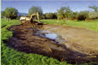
Neuanlage eines Laichgewässers in der Netheave.
